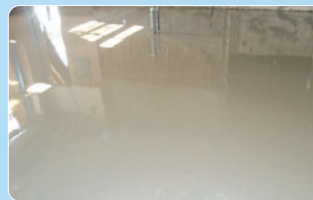
硬化するまでは窓等を締めて急激な乾燥を防いで下さい。硬化後はできるだけ乾燥条件をよくして下さい。
