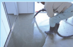
ポンプ圧送 材料に先立ちセメントのノロを送り込みバケツ等で受け、施工面には流さないで下さい。
