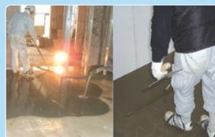
流し込みと定木、均し 隅から順に流し込み、トンボ等を使ってレベルに合わせて平滑に仕上げます。
